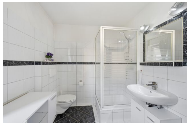
1.OG: Bad/WC mit Fenster, Dusche & Badewanne
