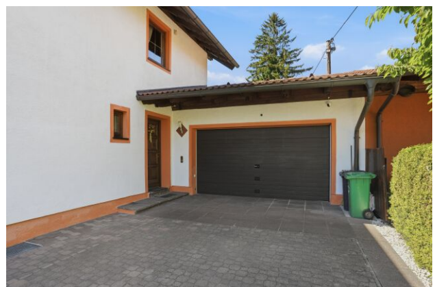
Doppelgarage mit elektrischem Tor. Überdachter Hauseingang.
