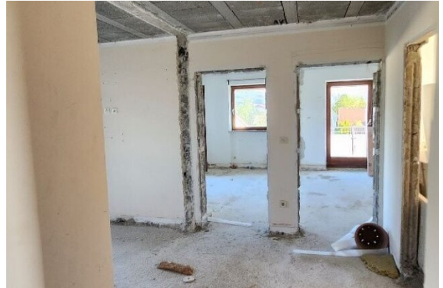
Bauzustand im Innenbereich
