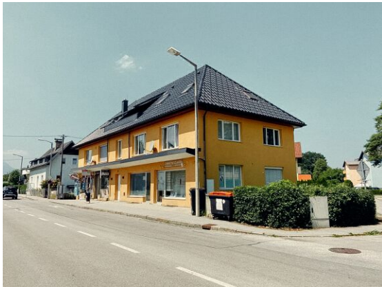
Südost-Ansicht mit Hauseingang: Eckwohnung im 1. OG rechts.
